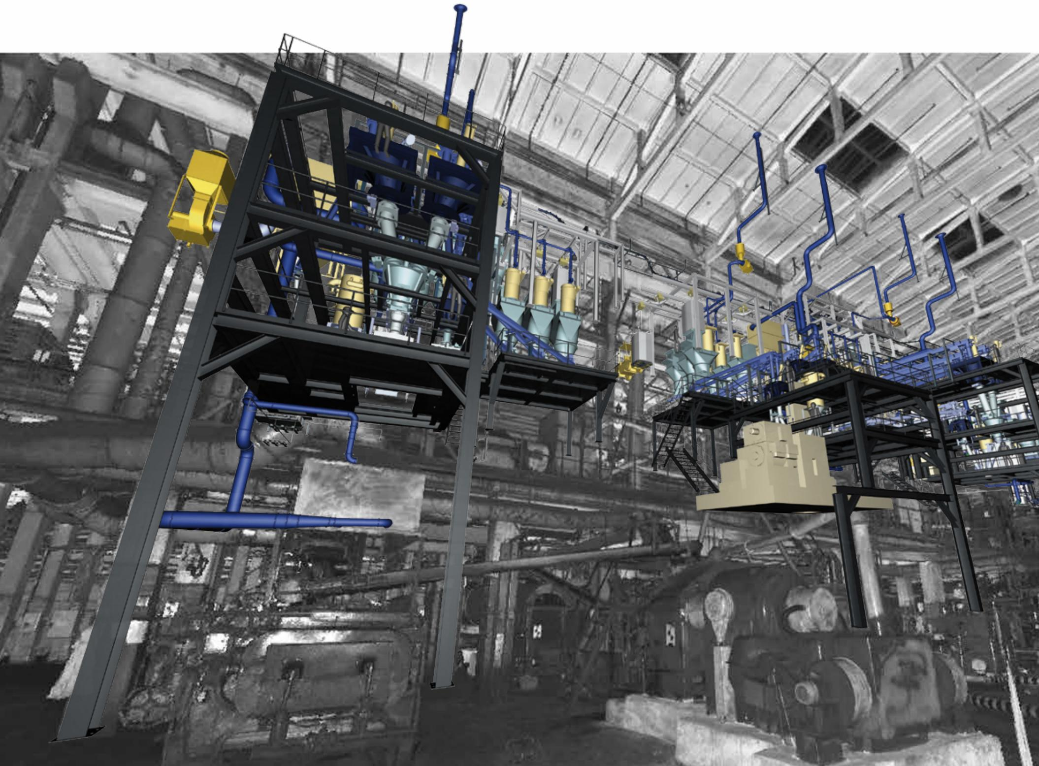
Auch bei Brown-Field-Projekten – also der Modernisierung oder Anpassung von bestehenden Anlagen – profitieren Sie von innovativer Zeppelin Technologie: Mit Laserscanning erstellen wir ein Modell Ihrer aktuellen Anlage.
