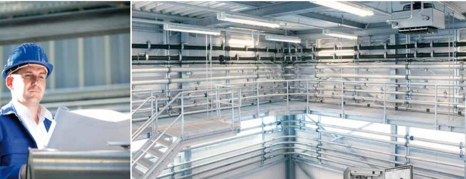
Entscheidend für eine produktschonende Förderung empfindlicher Schüttgüter wie Ruß oder Silika ist eine möglichst geringe Fördergeschwindigkeit. Um Staubfreiheit in der Anlage und der Umgebung sicher zu stellen, müssen die pulverförmigen Rohstoffe in geschlossenen Systemen pneumatisch gefördert werden.
