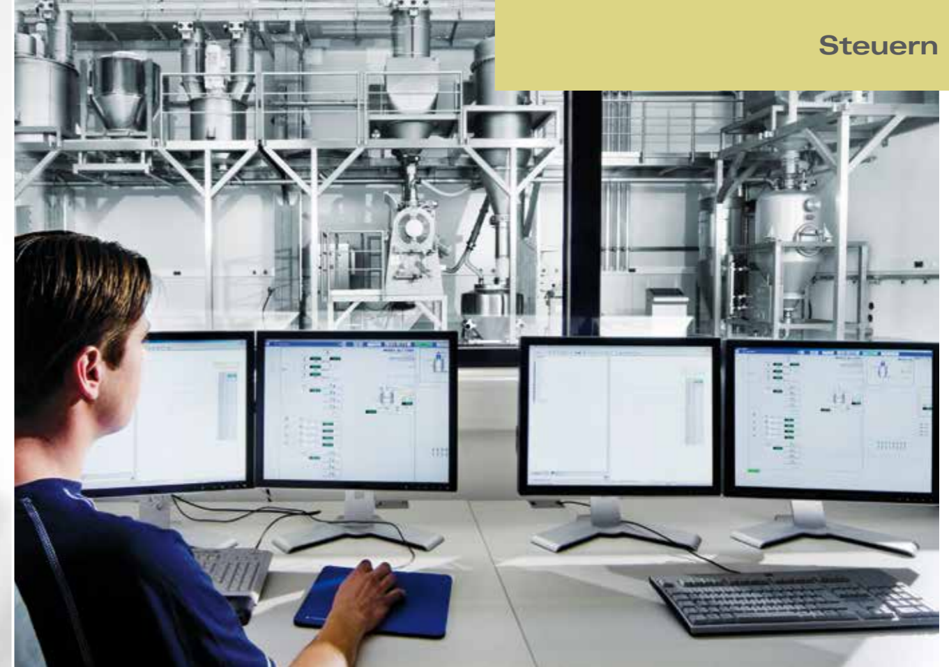
Steuerung der Anlagenprozesse
